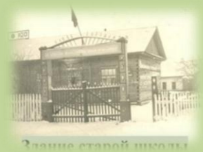
Здание старой школы
